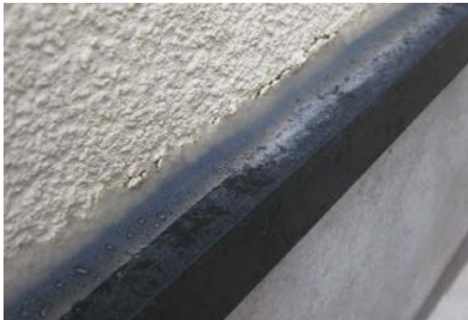
Spoji izvedeni s tesnilnimi trajno elastičnimi kiti
