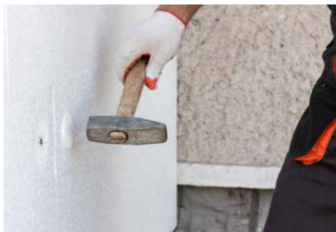
Primjer pravilno postavljene pričvrsnice
